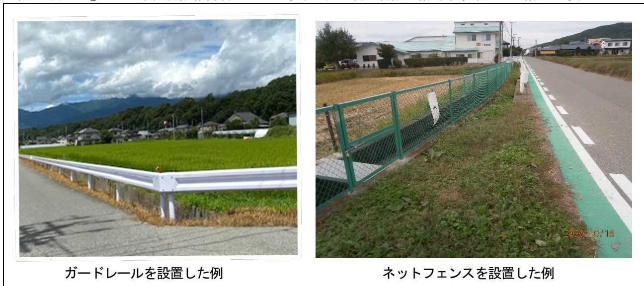
図表 2-(1)-7-⑤ 土地改良施設維持管理適正化事業（安全管理施設整備対策事業）で整備した事例
